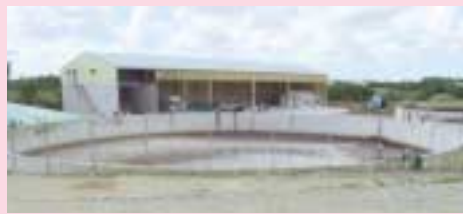
Vue d'ensemble de la station avec au premier plan le réacteur biologique. N'apparaît pas la lagune.
